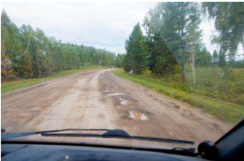
Промоины и лужи, трасса имеет повороты до 90 градусов. Рытвины на дороге, выбитые колёсами или вымытые дождями
