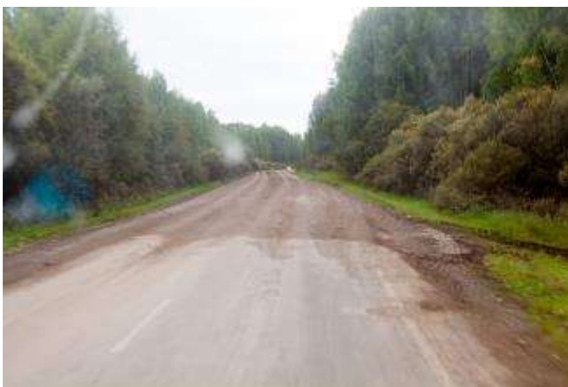
Стык асфальтовой и гравийно-грунтовой дороги
