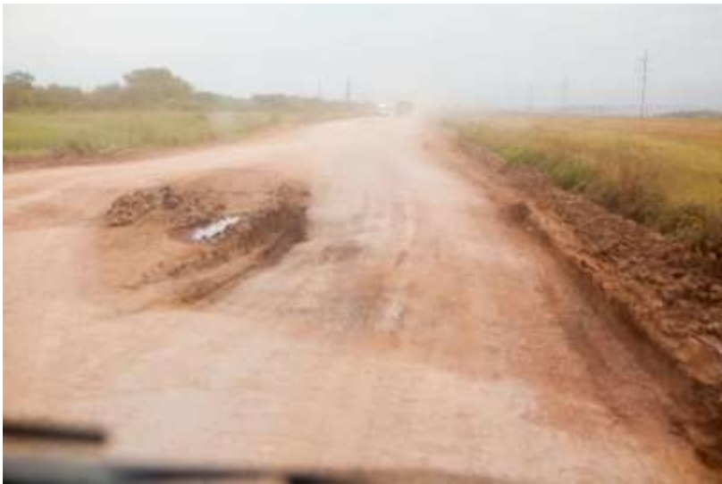
Просадка дорожного покрытия, в виде впадин с пологими краями (выбоины). Искривление профиля обочины Пыль от машин, недостаточная видимость.
