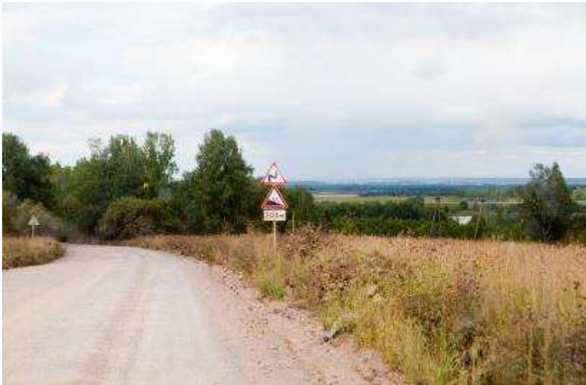
Уклон до 12%. Состояние дорожного покрытия: колеи, гребенка и рытвины. Нарушение целостности неукрепленной обочины.
