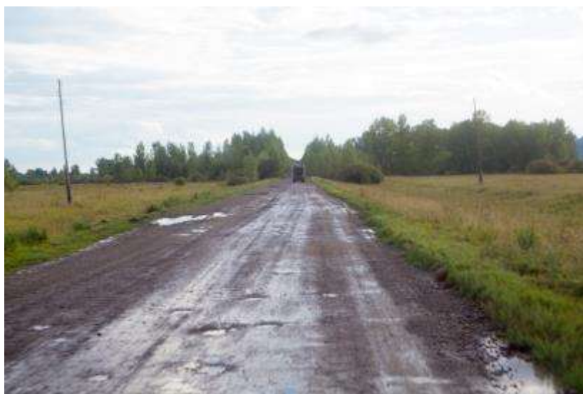
Гравийная дорога с изношенным покрытием, выбоинами имеющие вид углубления с резко очерченными краями, лужи
